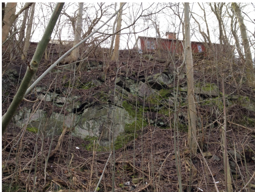
Foto 3. Brant bergsparti med växtlighet
