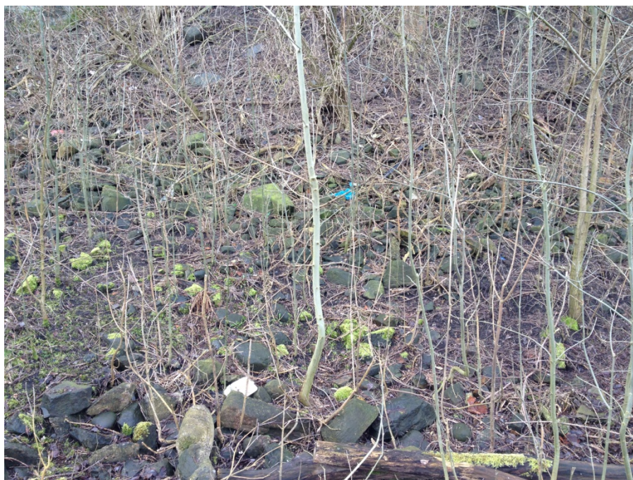
Foto 4. Utfallna Stenar och mindre block ansamlas i slänten och släntfot
